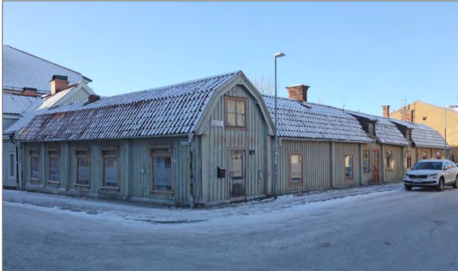
Garnboden i kvarteret Snickaren, hörnet Kungsgatan/Sandgatan, är ett av få bevarade hus från det tidiga 1800-talet. Storleken, fasadmaterialen och detaljerna ger en hint om hur stora delar av centrala Enköping såg ut innan rivningarna började i mitten av 1900-talet.
