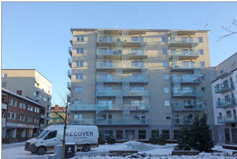
Åttavåningshuset i kvarteret Fältskären (hörnet Eriksgatan/Torggatan) färdigställdes i slutet av 2010-talet. Till vänster syns ett av de två sjuvåningshusen från 1960-talet längs Eriksgatan.
